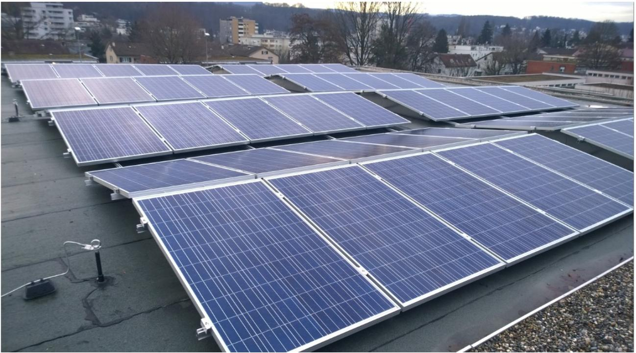
Die neueste Fotovoltaik-Anlage der Ökogemeinde ist auf dem Dach des Spiegelfeldschulhauses das dem Kanton Baselland gehört installiert. Sie produziert Solastrom seit dem 20. Dezember 2013. Die Panels sind für optimalen Jahresertrag nach der Sonne ausgerichtet.
