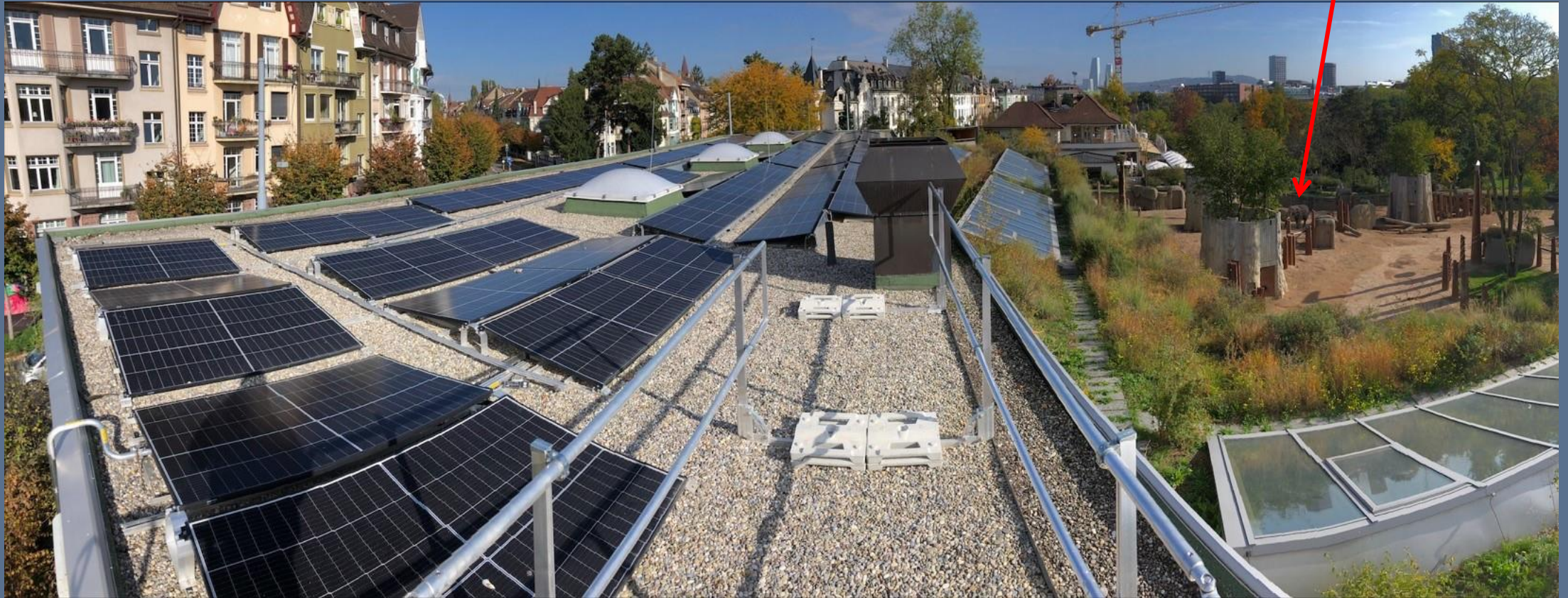
Weitere Anlagen: PV-Tembea 48 kWp (2022)
