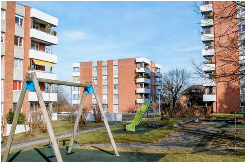
Früherer Zustand: Das neue Erscheinungsbild knüpft an die 1960er-Jahre-Architektur an.
